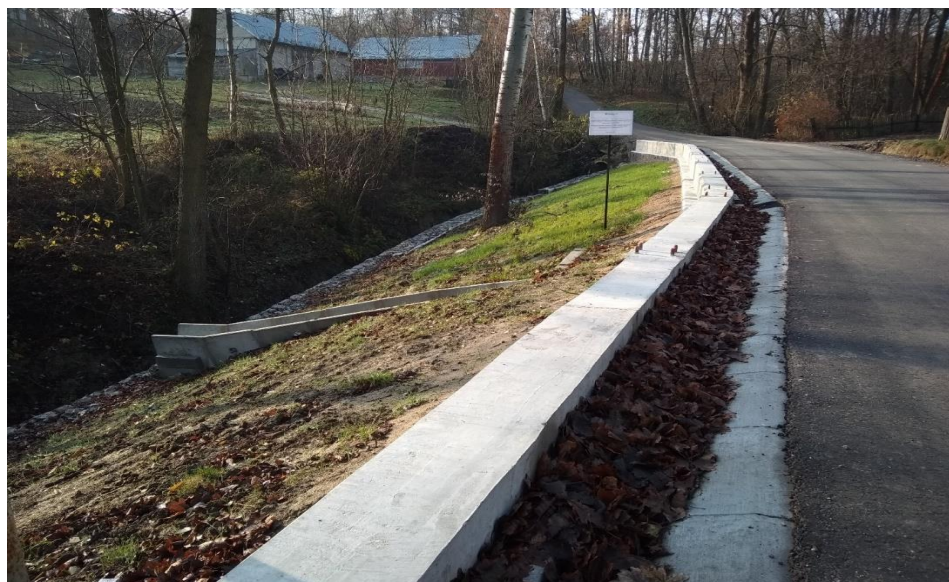
Rysunek 14. Zabezpieczenie osuwiska przy drodze gminnej w Husowie
