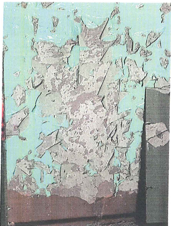
21. Powłoki malarskie wewnątrz.
