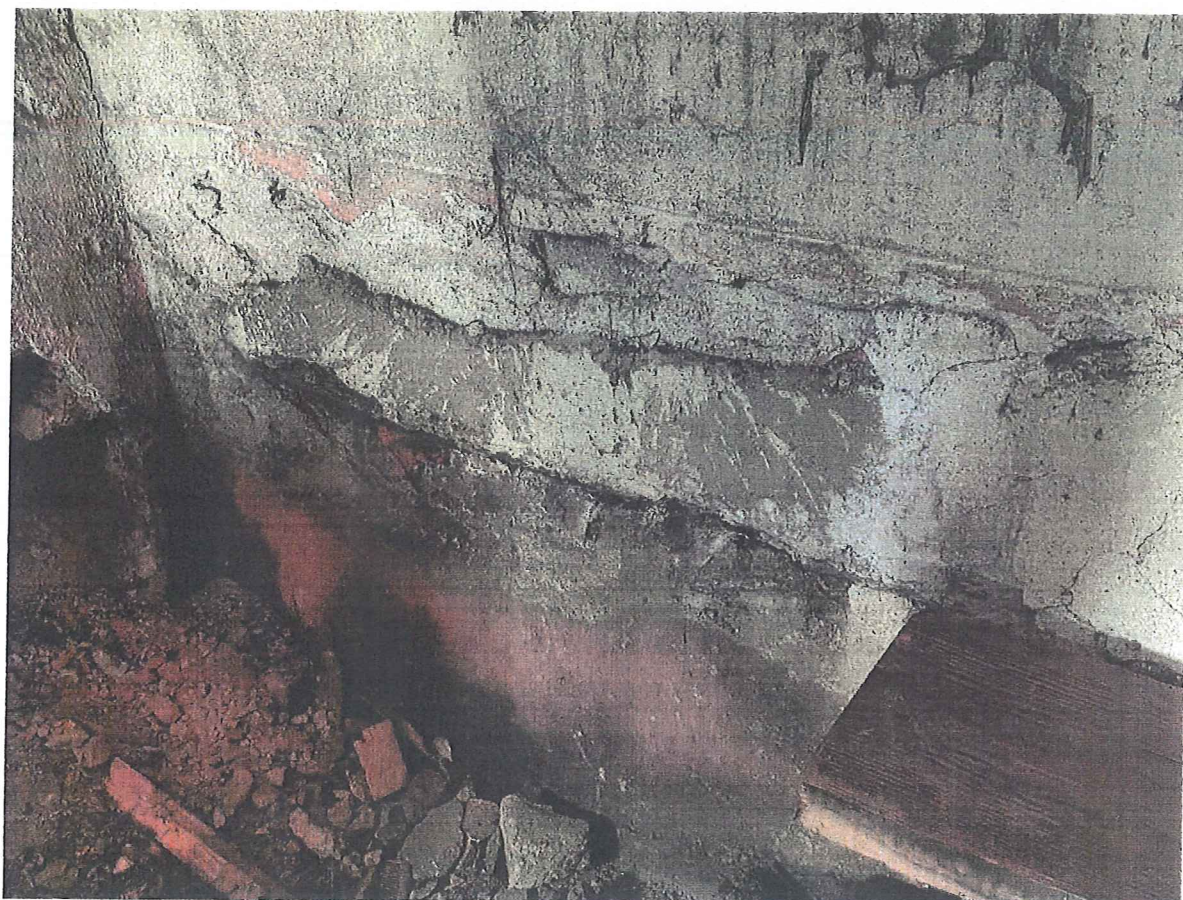
23. Fragmenty izolacji poziomej, odkrywka w sali widowiskowej.
