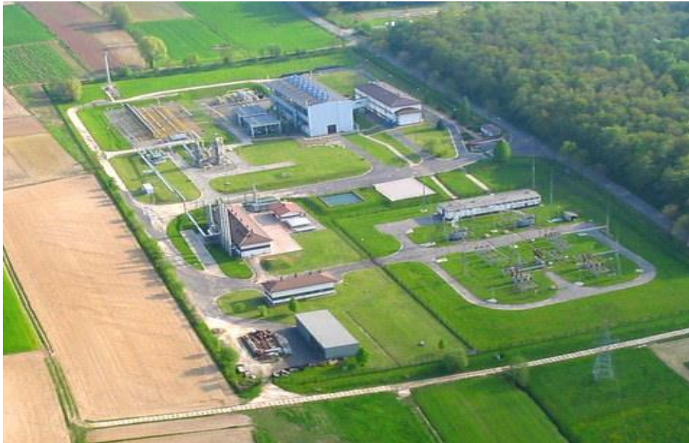
Rysunek 2. Podziemny Magazyn Gazu Husów – widok z góry
