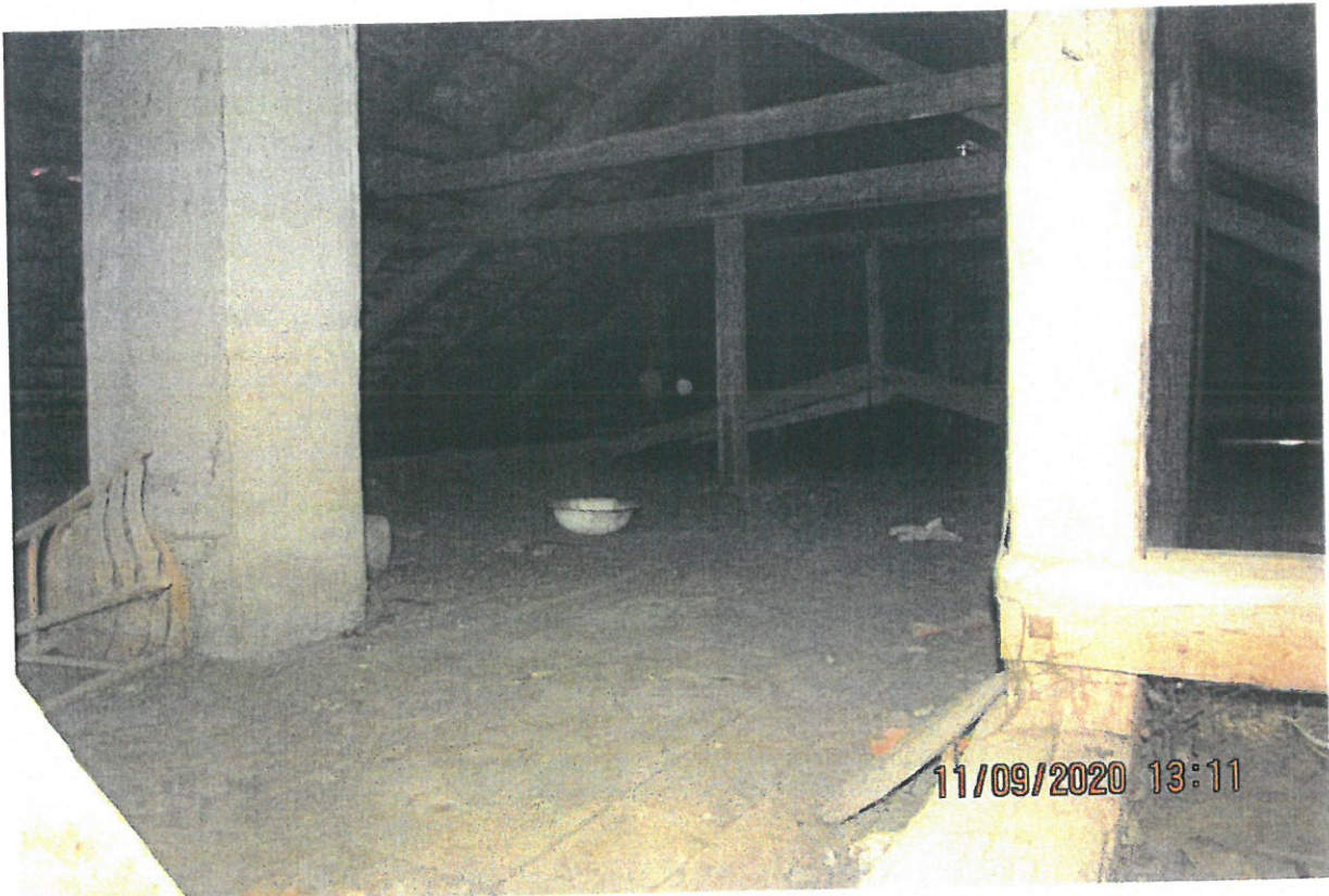
Fot. 4. Konstrukcja dachu
