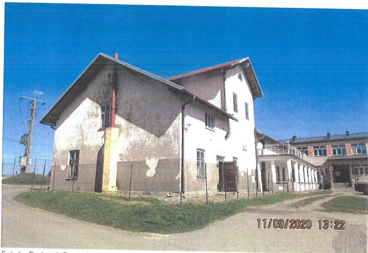
Fot. 1. Budynek Domu Ludowego
