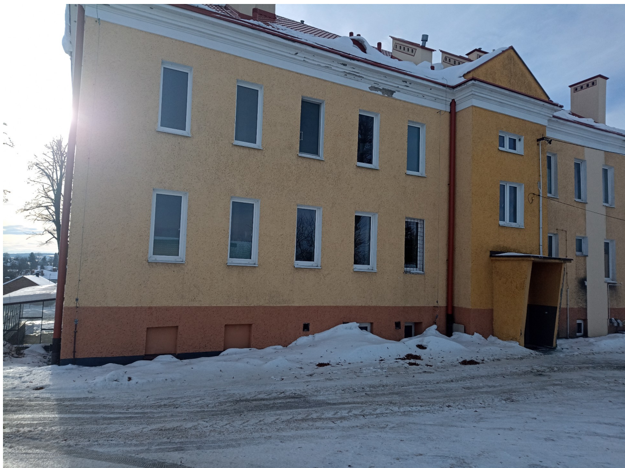
Ilustracja 1: Widok od strony północnej – część budynku na Klub Seniora - przyziemie
