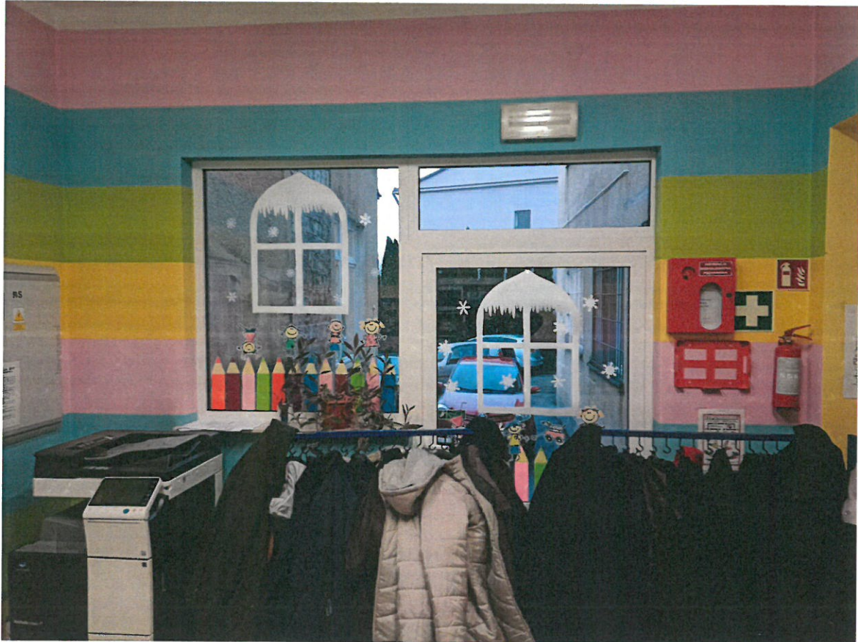
Ilustracja 4: Widok od wewnątrz budynku - w miejscu drzwi do planowanego wiatrołapu
