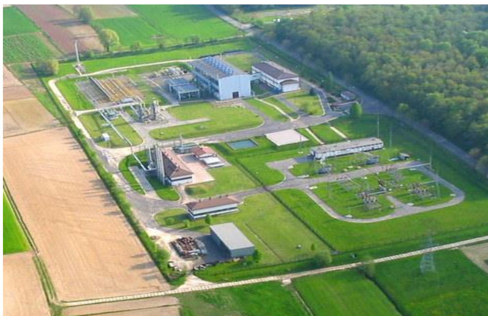
Rysunek 5. Podziemny Magazyn Gazu Husów – widok z góry
