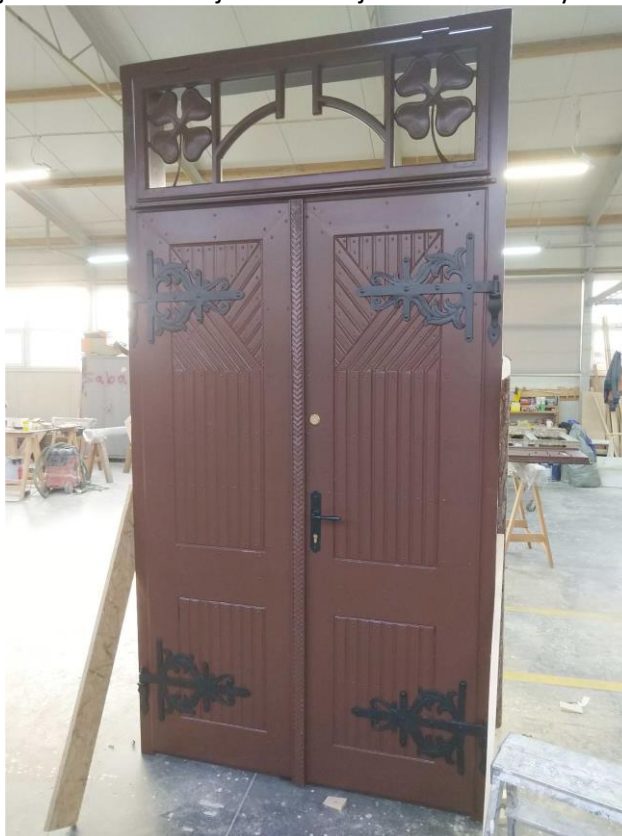
Rysunek 20. Konserwacja stolarki okiennej i drzwiowej w Domu Ludowym
