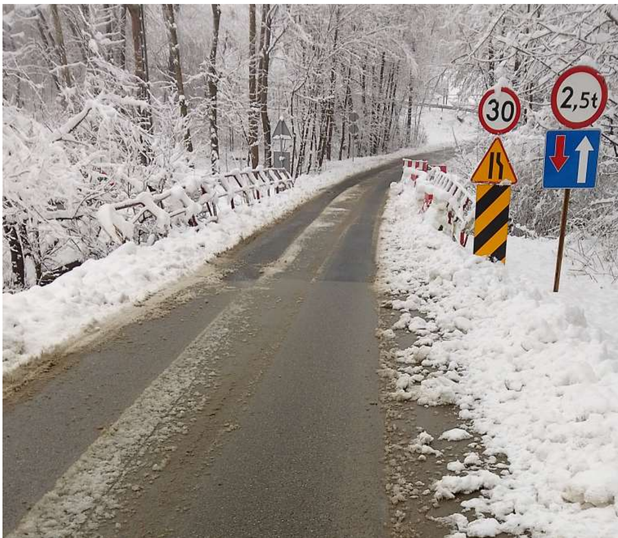
Fot 1. Widok mostu z góry.
