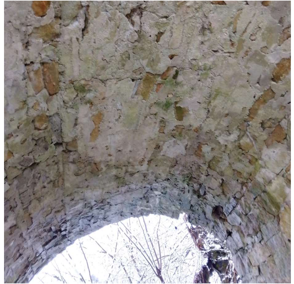
Fot 8. Widok - wylot - podpora prawa.
