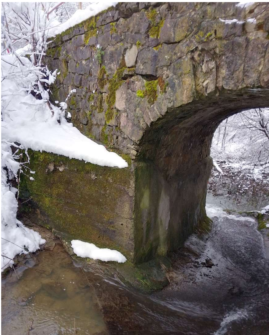
Fot 3. Widok - wlot - podpora lewa.
