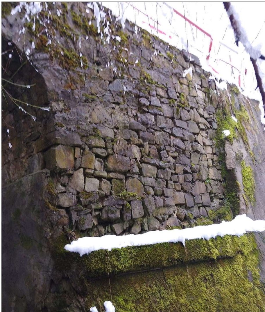
Fot 7. Widok wylot - podpora lewa.
