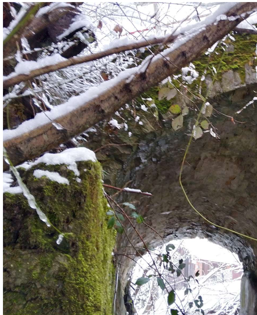
Fot 8. Widok - wylot - podpora prawa.
