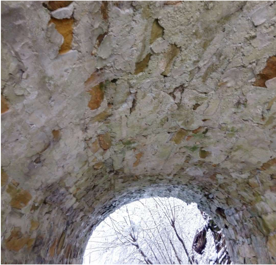
Fot 7. Widok wylot - podpora lewa.
