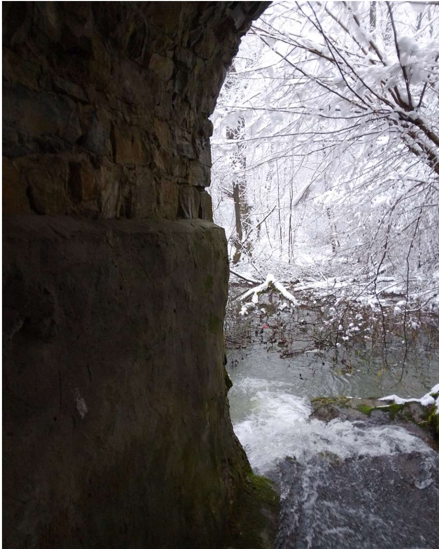
Fot 5. Widok wylot - podpora lewa.
